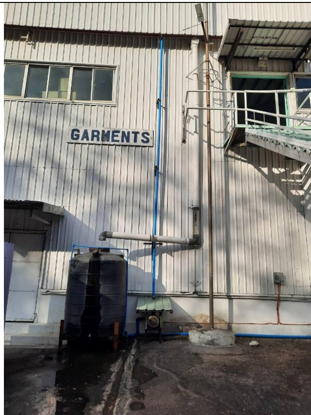
將屋面噴淋後的水，收集起來，在用水泵打到屋面，循環利用
